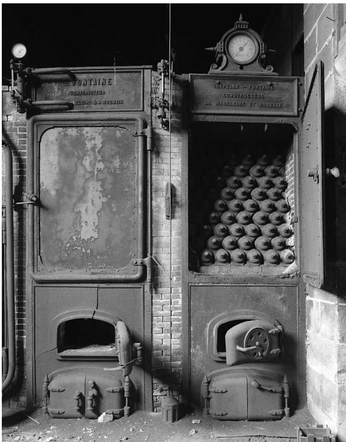
Fig.9 Détail de deux chaudières à vapeur tubulaires. Celle de droite porte l'inscription du constructeur "CREPELLE - FONTAINE / CONSTRUCTEUR / LA MADELEINE ET ROUBAIX". Celle de gauche porte l'inscription "L. FONTAINE / COSTRUCTEUR / A LA MADELEINE & A ROUBAIX".
