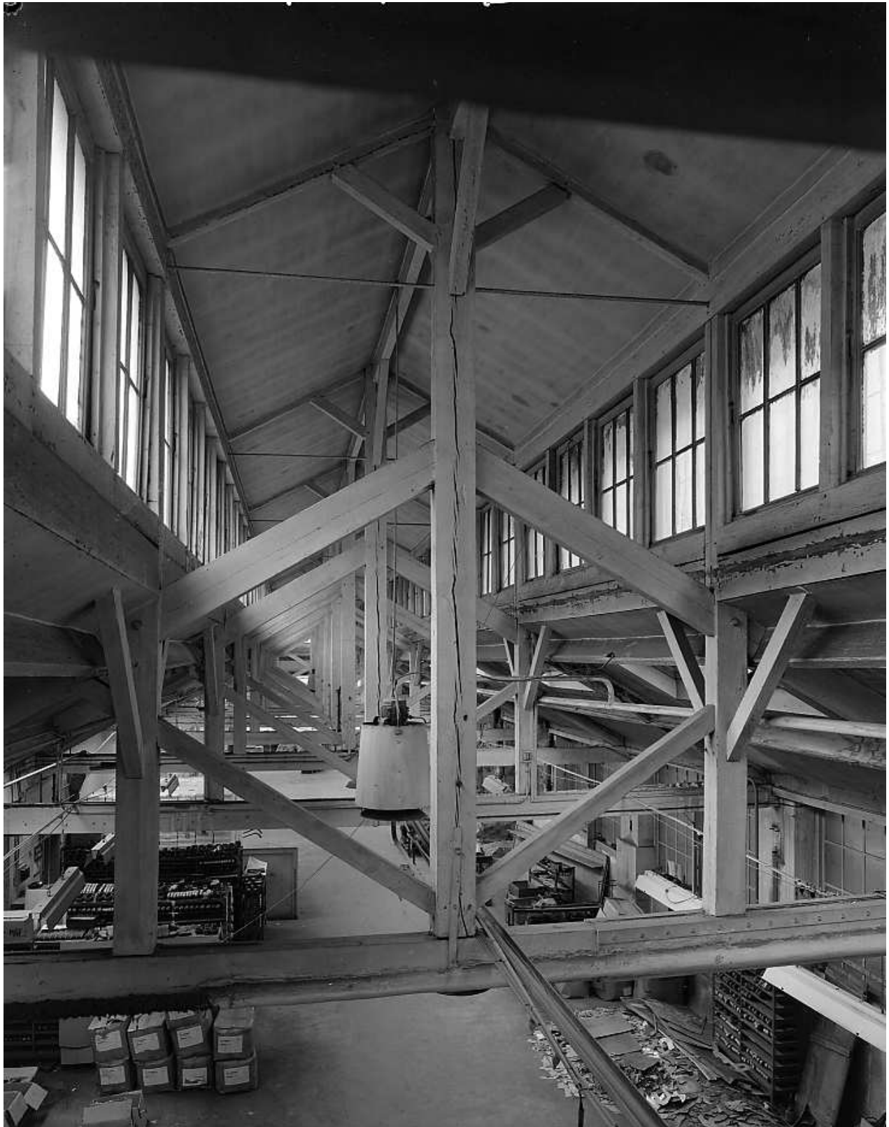
Fig.23 Rez-de-chaussée d'un atelier. Détail d'une charpente et d'un lanterneau aménagé pour l'éclairage.
