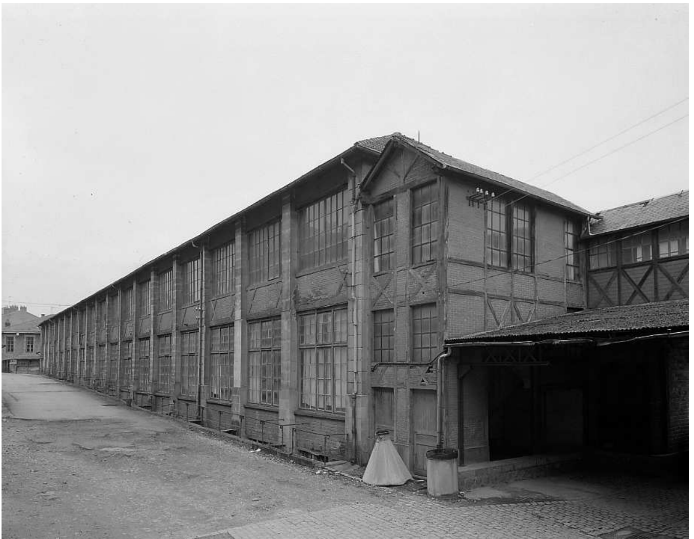
Fig.16 Façade ouest des ateliers de collage et tressage de l'usine de chaussures (en 1893 le rez-de-chaussée serait affecté au stockage du bois. Extrémité Sud de la façade : cage d'escalier desservant l'étage.
