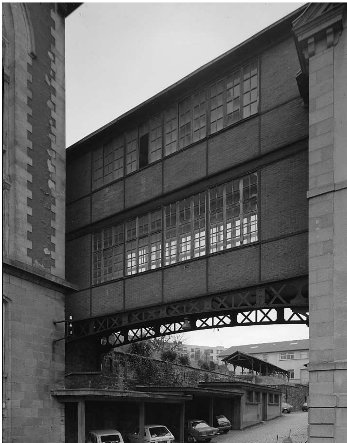
Fig.10 Passerelle reliant les bureaux et magasins de l'usine de chaussures et la partie ouest de l'usine entre le bâtiment sud et les bâtiments est. Cette passerelle reliait en 1893 les ateliers de tournage et moulage (anciens ateliers de décoration de 1853) à l'atelier de fabrication des assiettes. A gauche, le pignon de la salle des machines.
