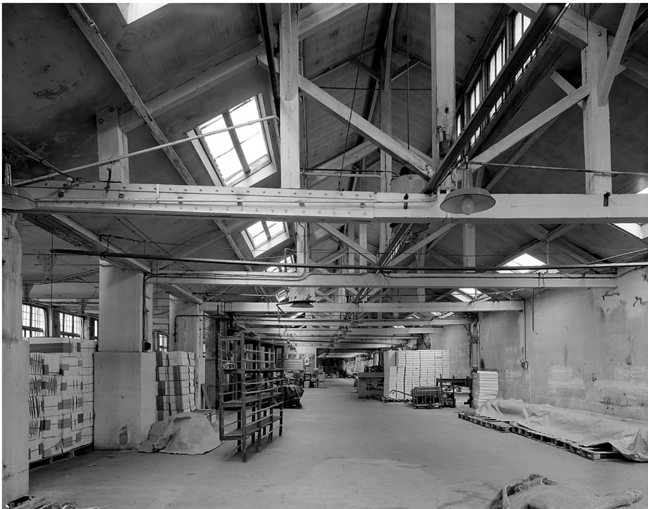
Fig. 22 Vue intérieure d'un atelier ( anciens ateliers de préparation et de coupe ?). Cet atelier, sans doute édifié entre deux ateliers préexistants, présente divers types d'éclairage zénithaux.
